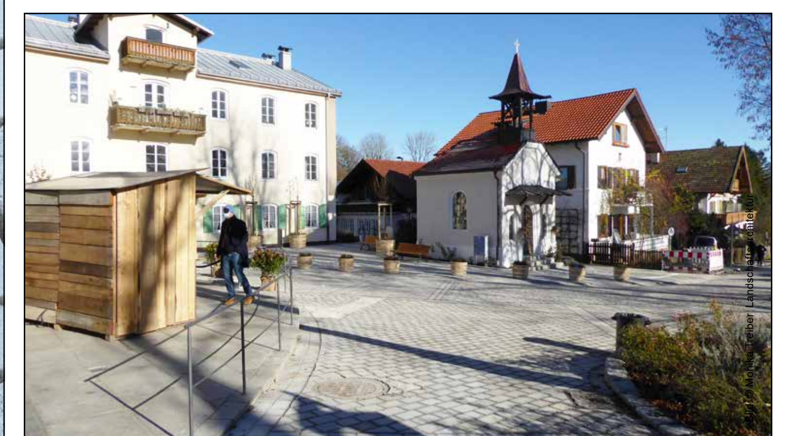
Bild 19: Platzsituation mit Blick von der Fischmeisterstraße
