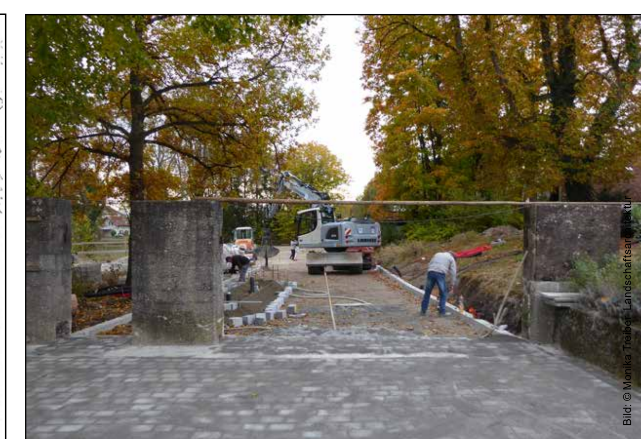
Bild 25: Wiederherstellung der Toranlage des ehem. Lazarett
