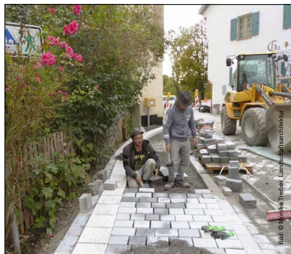
Bild 10: Pflasterer bei der Arbeit
