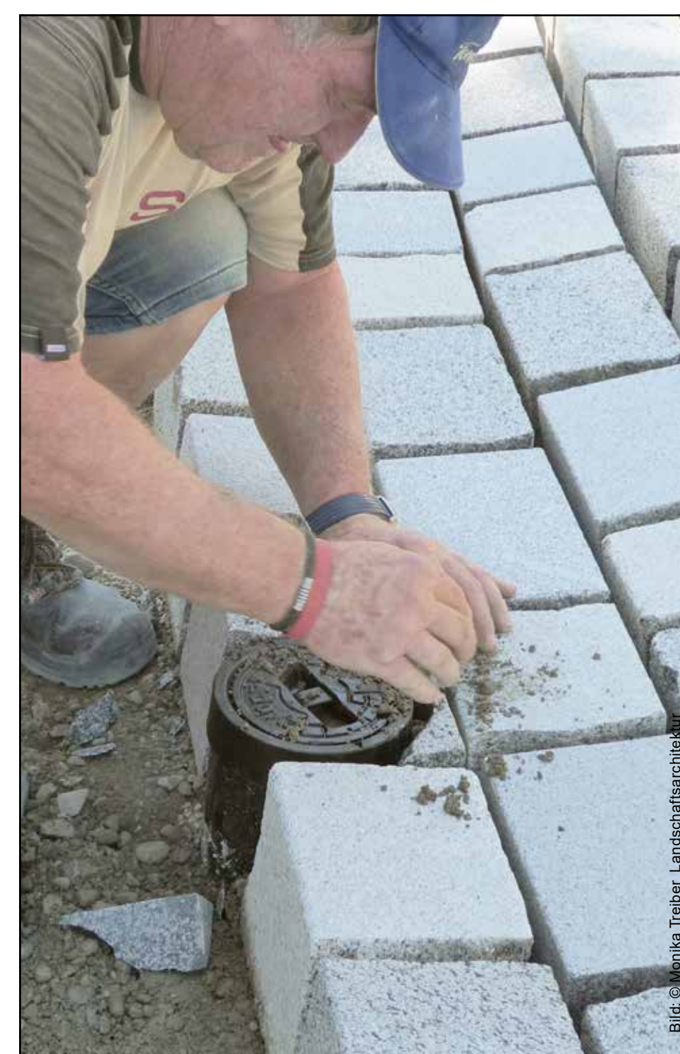
Bild 16: Ausarbeiten eines Pflasterdetails
